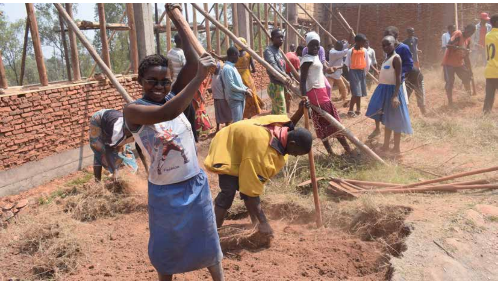
Pendant les travaux communautaires
